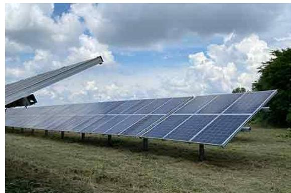
*Figura 2.6: Particolare strutture di sostegno moduli*
