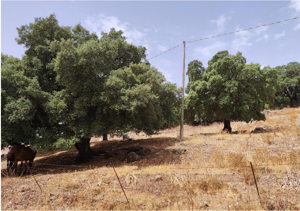
Figura 2.3: Linea aerea di bassa tensione BT_A01(40.81427997, 8.78205200).
