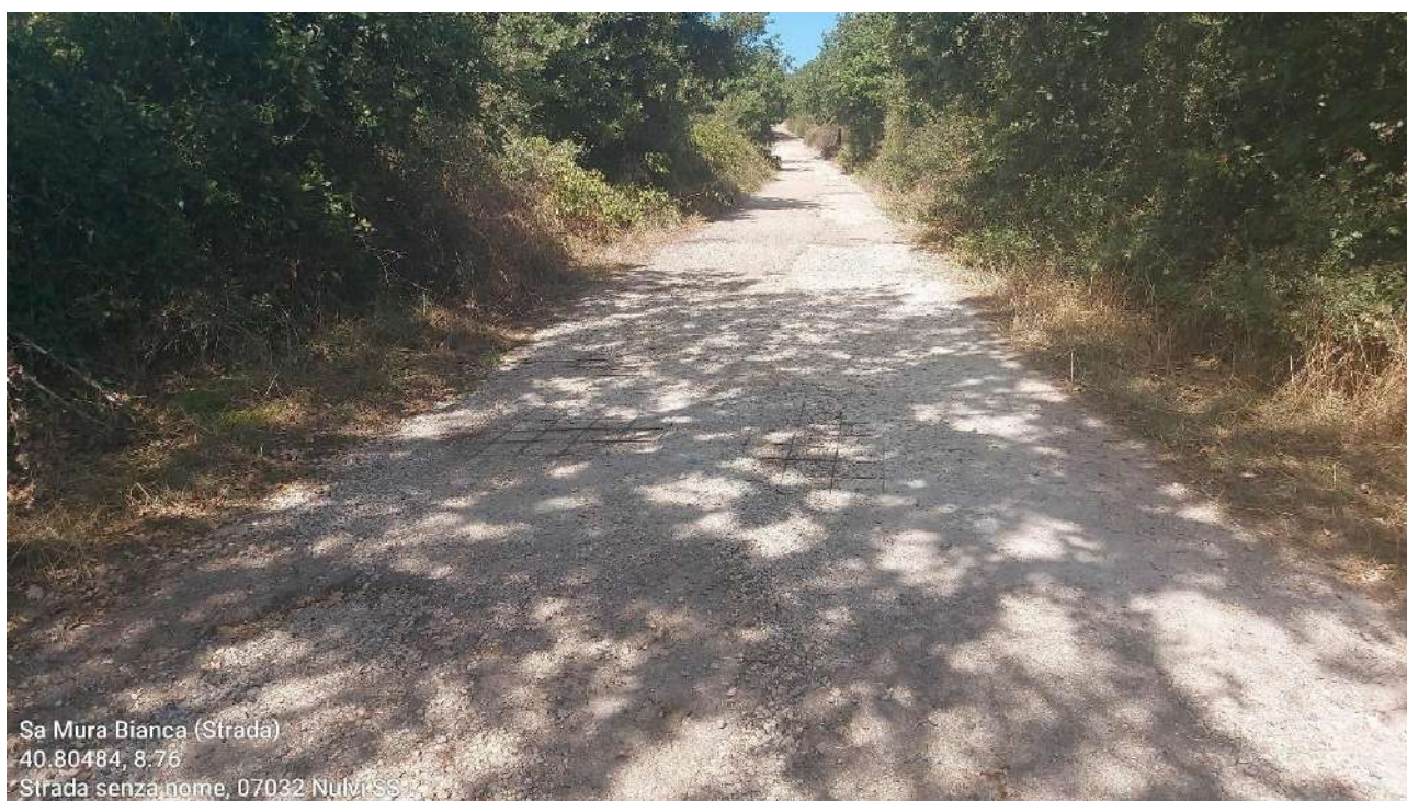
Figura 19. Nulvi, strada comunale di penetrazione agraria: porzione interessata dal tracciato del cavidotto in progetto.
