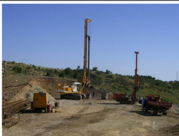
Realizzazione pali trivellati
