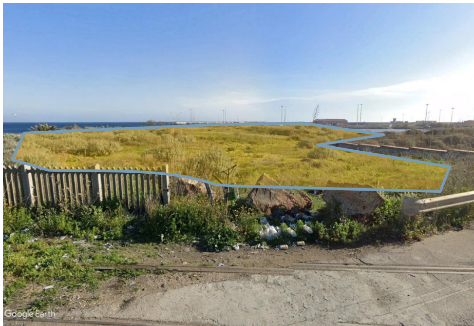
Figura 6.3: Area stoccaggio e cantiere per il varo dei pannelli
