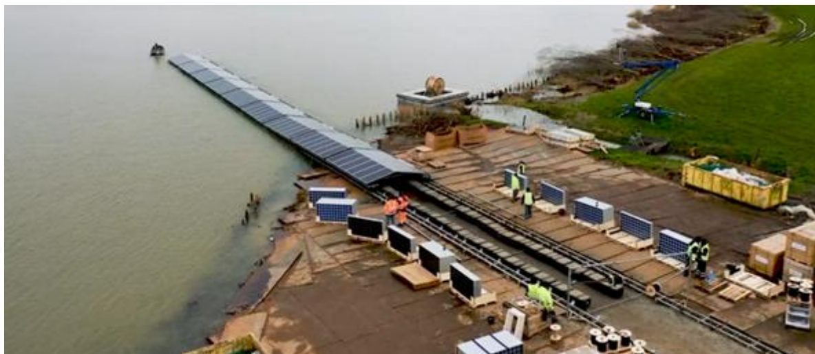
Figura 6.6: Varo dei moduli fotovoltaici (Fonte:BayWa r.e.)
