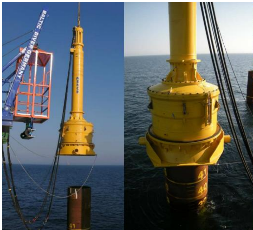
Figura 6.5: Esempio di battitura pali a mare (fonte Menk)
