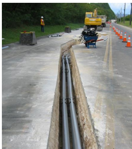
Figura 6-11 esempio di scavo per interrimento su asfalto
