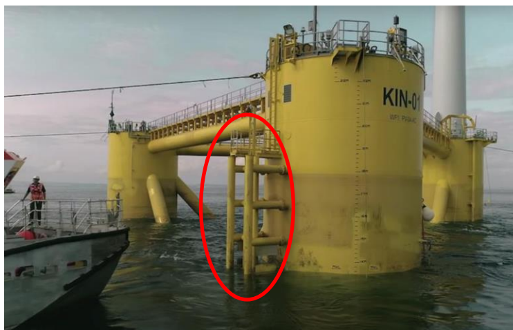
Figura 7-1 Esempio di Boat Landing (riferimento Offshore wind Kinkardine)
