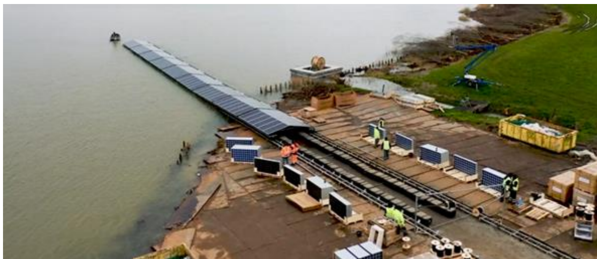
Figura 4-10: Varo dei moduli fotovoltaici in mare tramite scivolo composto da rulli
