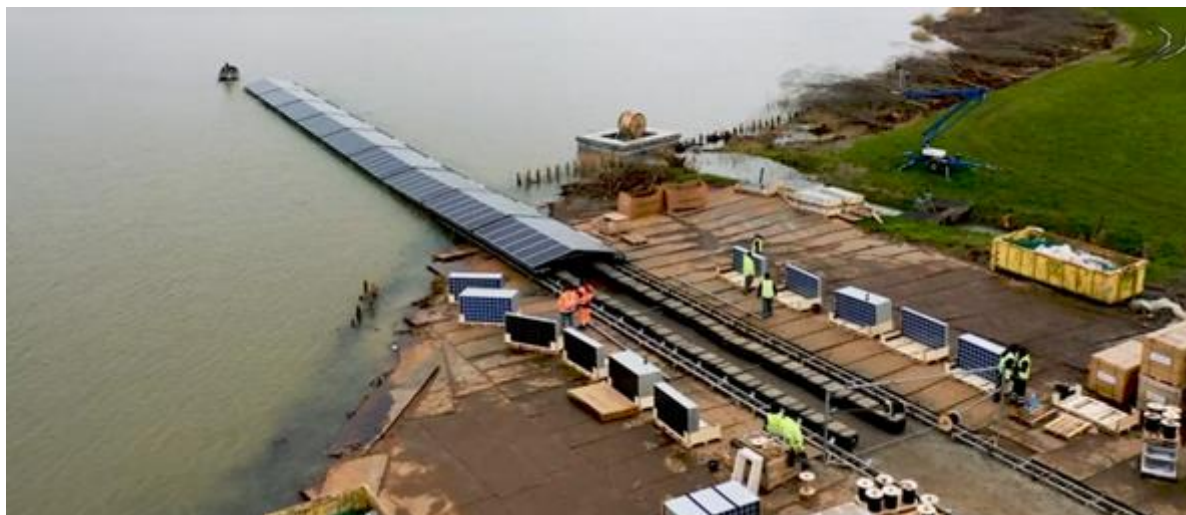
Figura 58: Varo dei moduli fotovoltaici (Fonte:BayWa r.e.)
