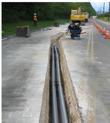
Figura 62: Esempio di scavo per interrimento su asfalto
