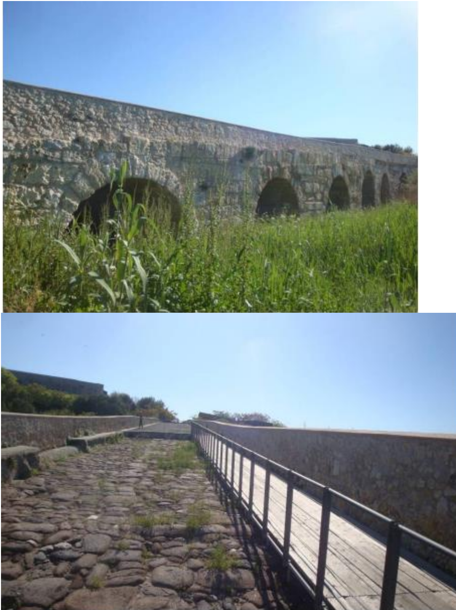
Figura 4: Particolari del Ponte Romano
