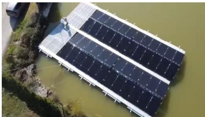
Figura 44: Esempio di pannelli fotovoltaici su piattaforma galleggianti
