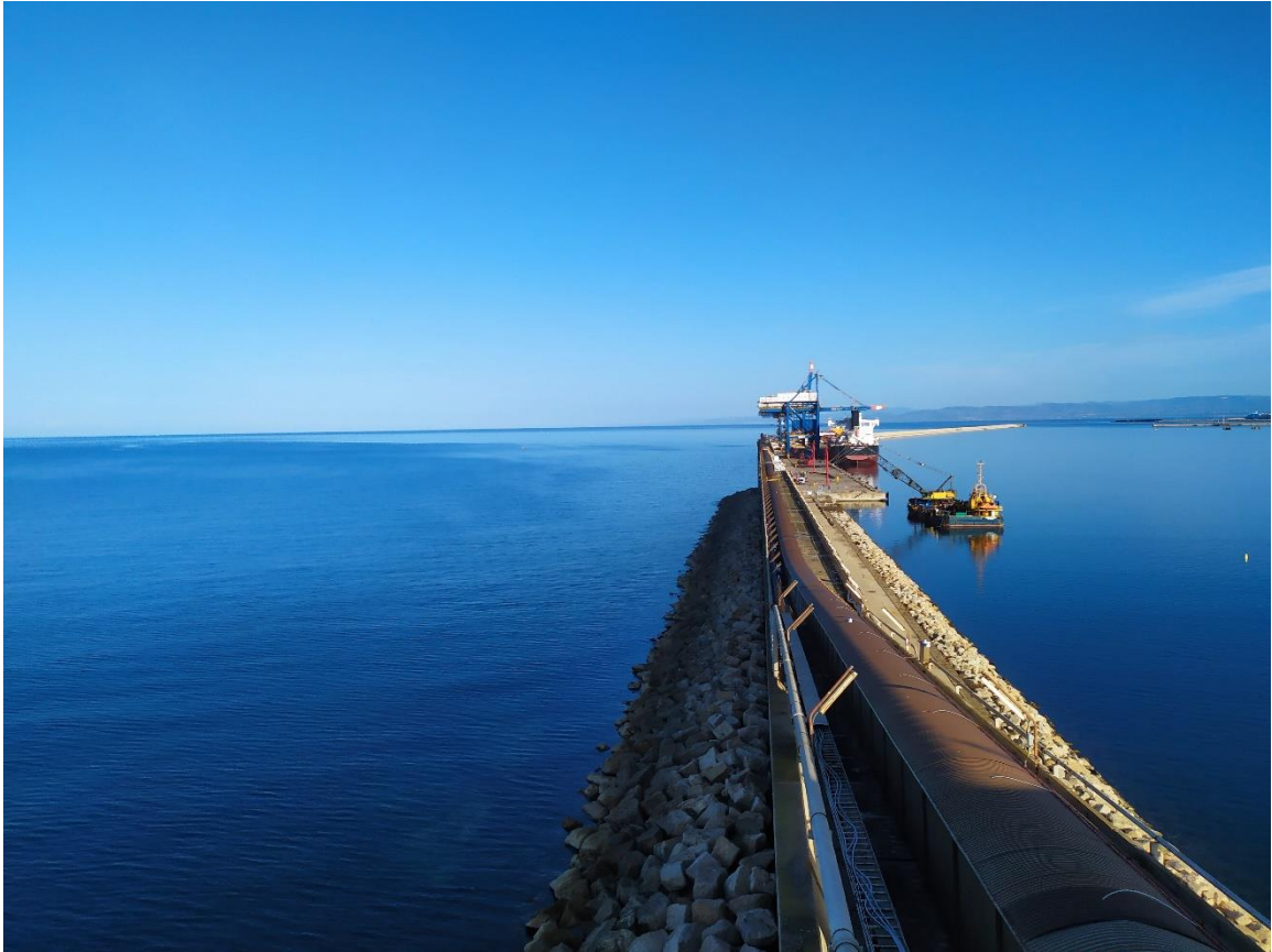
Figura 11: Vista attuale dell'area di posizionamento dei moduli fotovoltaici dal carbonodotto sulla diga foranea (PP1)
