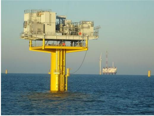
**Figura 5-4: Esempio di monopali per cabine contenenti trasformatori BT/MT**
