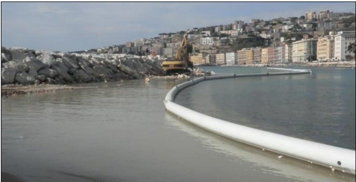
Figura 18: Utilizzo di barriere anti-torbidità durante i lavori
