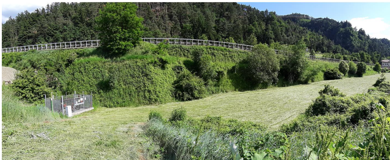
Figura 27: vista panoramica da Nord del rilevato della Sp27 in cui è prevista la realizzazione dell'imbocco della finestra Funes .
