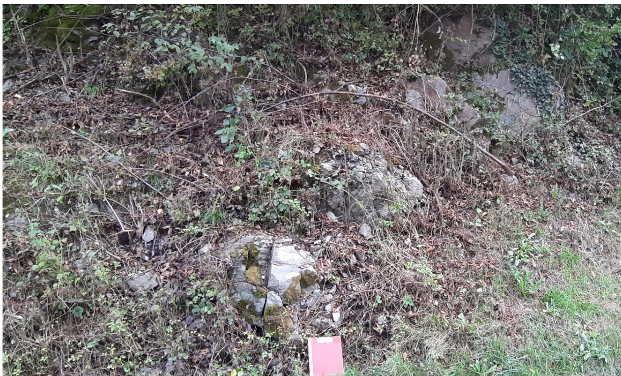
Figura 31: estremità dell'affioramento roccioso lungo la scarpata della SS242dir, a circa 50 m dall'inizio della nuova viabilità NV072 all'altezza dell'incisione laterale presente a monte della strada .
