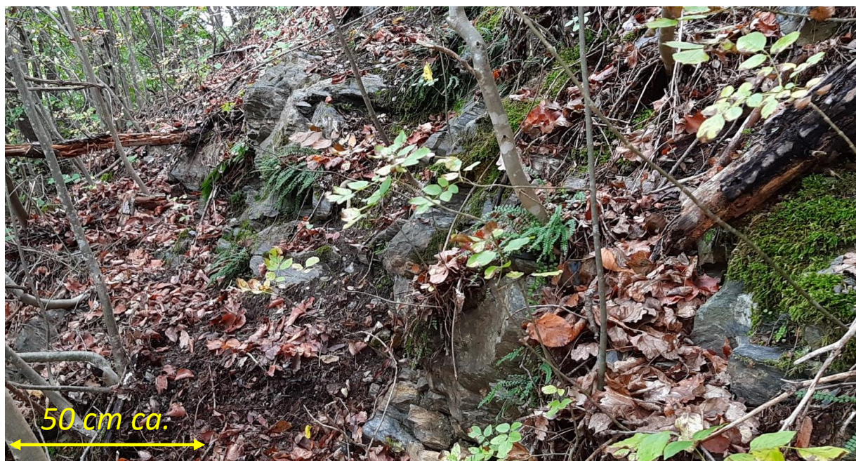
Figura 30: affioramento di filladi nella parte bassa della scarpata di monte della SS242dir all'altezza dell'attacco della paratia di sostegno della nuova viabilità NV072 .
