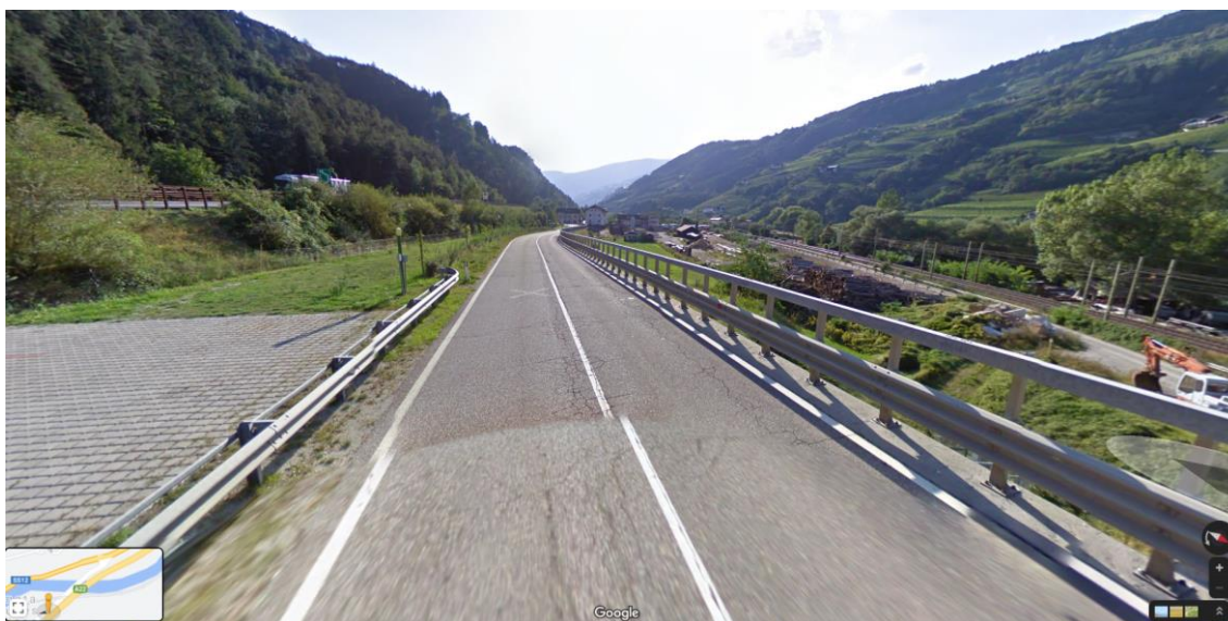
Fig. 3 – Immagine da Google Street View – Fotografia della carreggiata della SP a inizio lotto, in prossimità della spalla del viadotto
