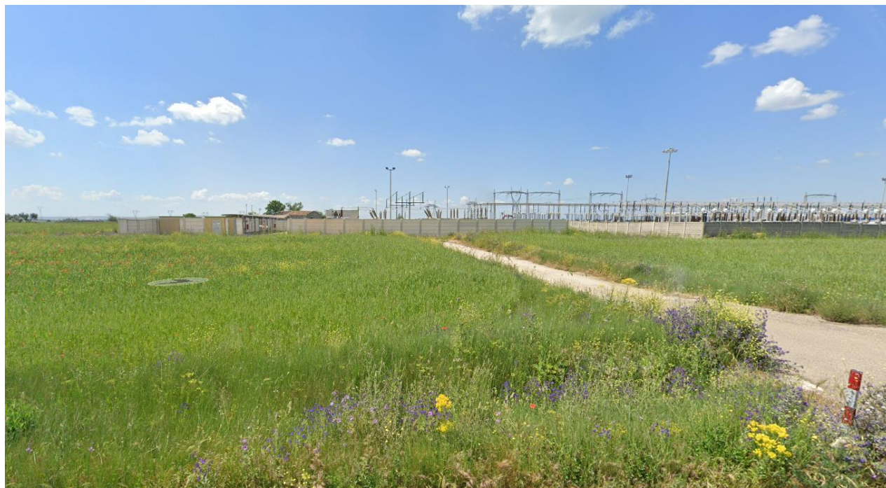
Figura 2.21: Documentazione fotografica – stato di fatto – SEU
