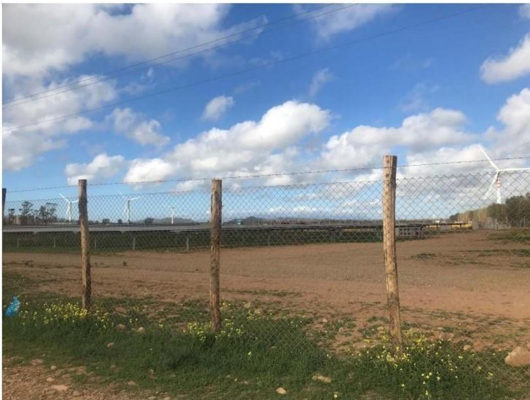
*Figura 0.2 Esempio di recinzione perimetrale con pali in castagno e rete metallica romboidale*
