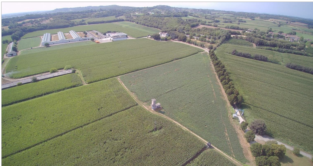
Figura 4.2 Visuale dell'area oggetto di intervento in direzione Nord
