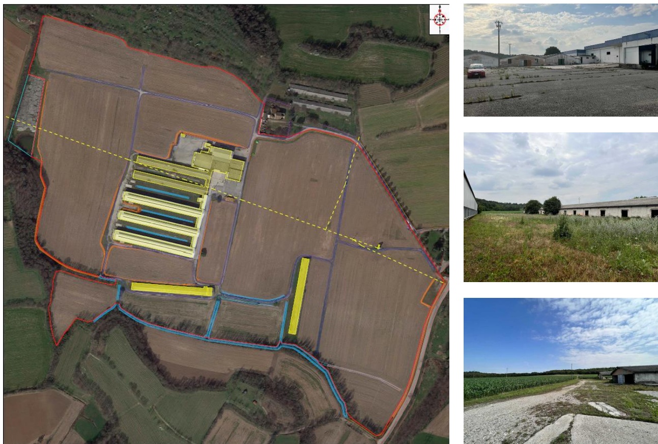
Figura 4.4 Ortofoto dell'area di progetto con individuazione dei fabbricati oggetto di demolizione (in giallo) e relativa documentazione fotografica
