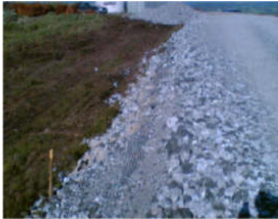
Figura 19: Superficie stradale in misto stabilizzato e drenaggio
