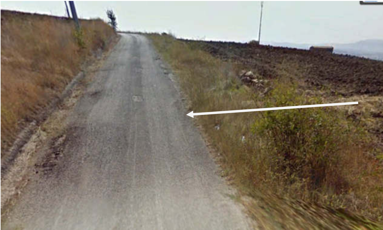
Figura 37- Inserimento del cavidotto sulla sede stradale del tratturello.
