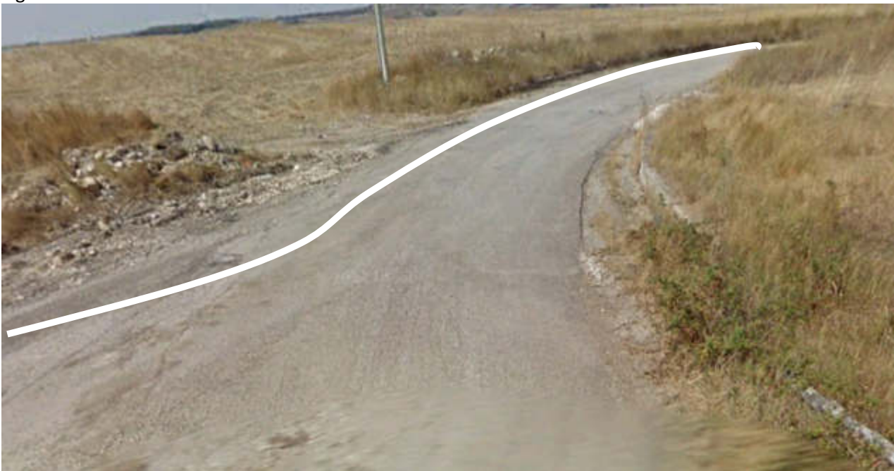
Figura 38- Ultimo tratto del cavidotto sulla sede stradale del tratturello con deviazione verso la BCN 04.
