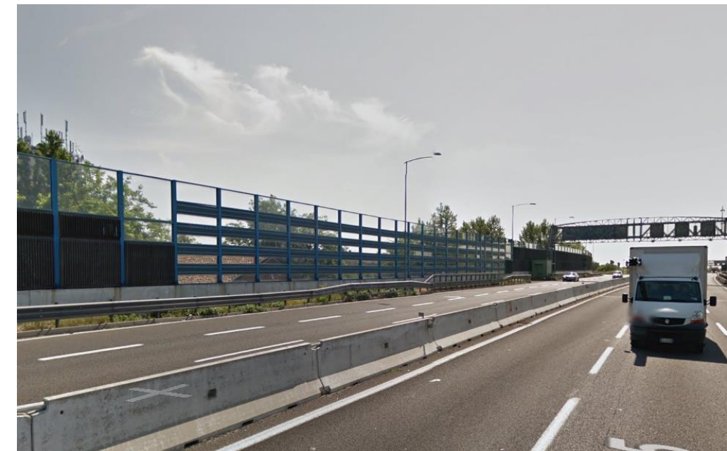
Figura 3-1 - Mitigazioni acustiche presenti lungo la Tangenziale di Bologna
