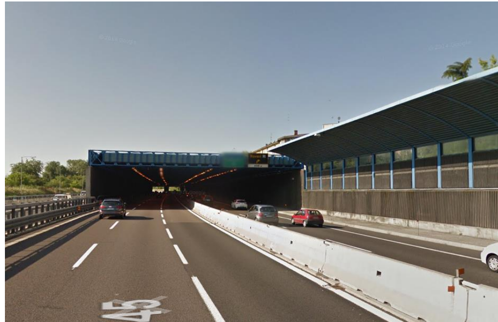
Figura 3-2 - Mitigazioni acustiche presenti lungo la Tangenziale di Bologna
