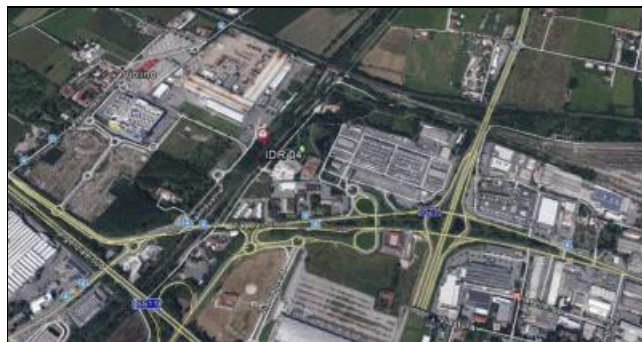
SITO IDR 04 AEREA
