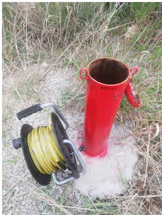
* foto rappresentative della postazione di misura AST11
