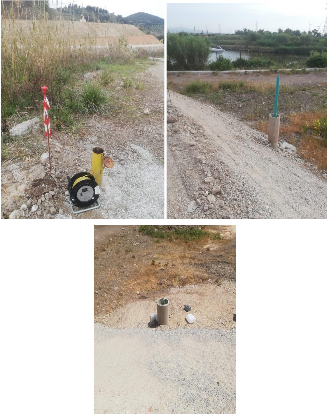
Figura 11 Variazione della quota del boccapazzo del piezometro AST10 dalla campagna di marzo (foto alto a sx) alla campagna di maggio (foto alto dx). Nella foto in basso il ripristino dell'accesso al PZ nella campagna di giugno.
