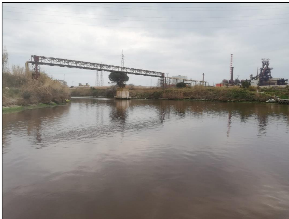
Figura 6 Punto di monitoraggio ASP06
