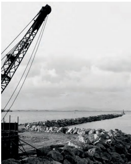
Figura 7-6: Inizio lavori nel porto industriale presso lo stagno di Gennano
