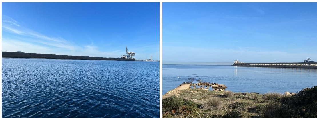
Figura 6-8: Diga foranea, vista dal mare, sviluppo verso ovest (a sx), Parte a mare del cavidotto presso diga foranea (a dx)
