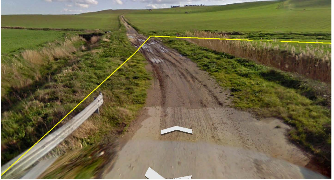
Figura 8- Passaggio tracciato strada interpodereale direzione sud
