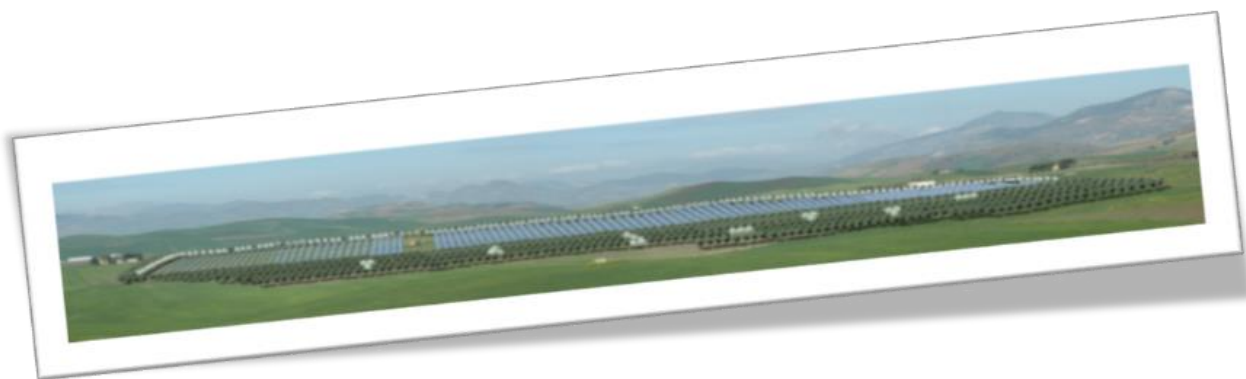
Figura 36 - Impianto fotovoltaico da 5 MW, "Heliospower", Monreale (PA) 2010
