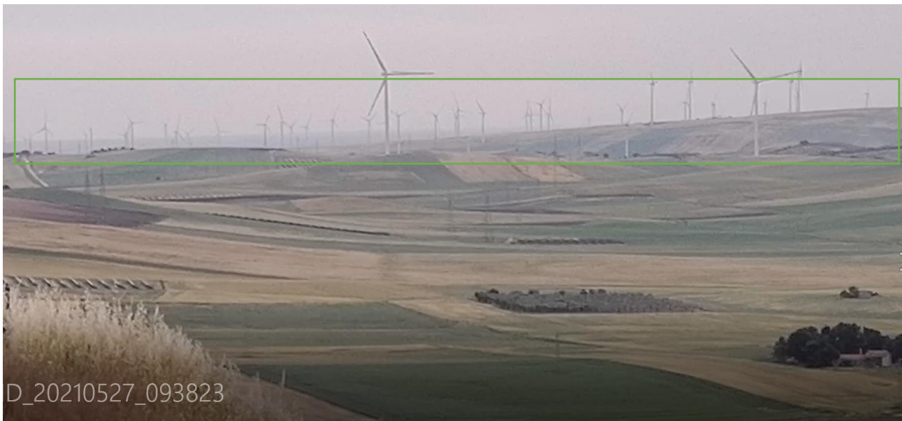
Figura 52 - Impianti eolici, tralicci Enel e area di impianto
