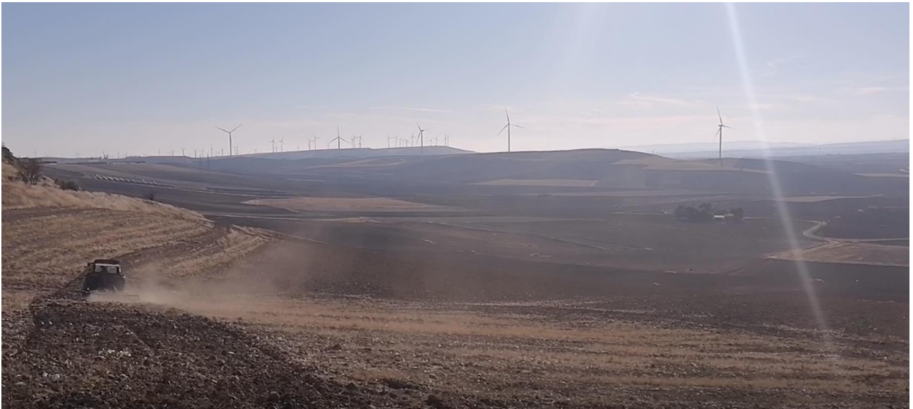
Figura 65- Veduta complessiva del territorio e dell'area di impianto
