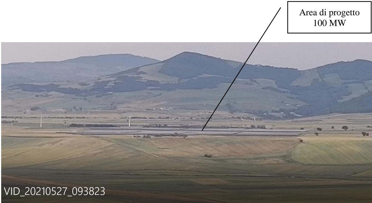
Figura 51 - Veduta frontale dell'impianto da 100 MW
