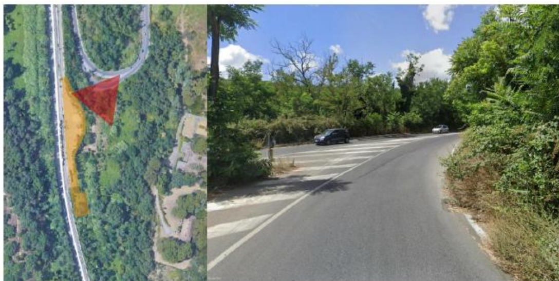
Figura 22 – Area di cantiere AT1-01 e CB-01 Tipologia di visuale in territorio aperto con visibilità bassa
