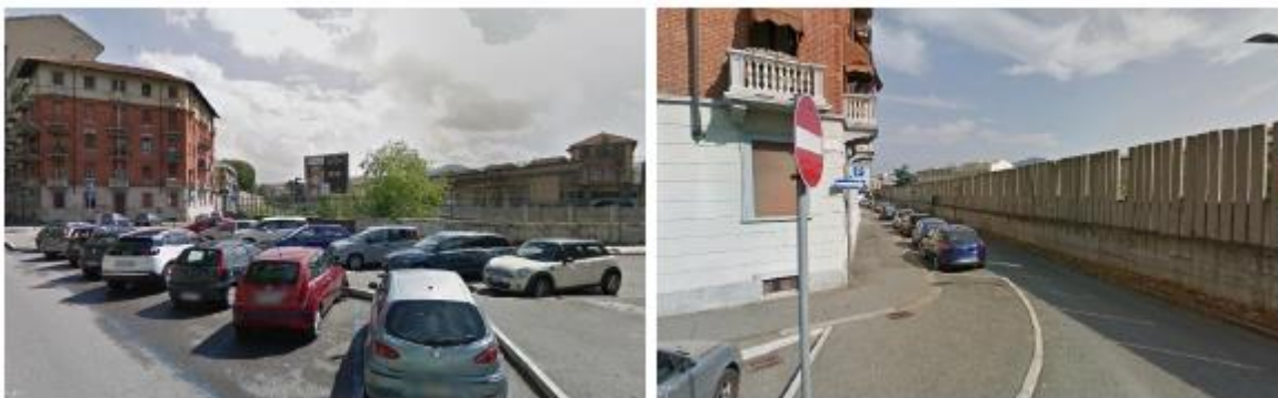
Figura 19 – Via Jonio. Visuale sul tratto di linea in trincea oggetto di inserimento di barriere antirumore, in sostituzione degli elementi attuali
