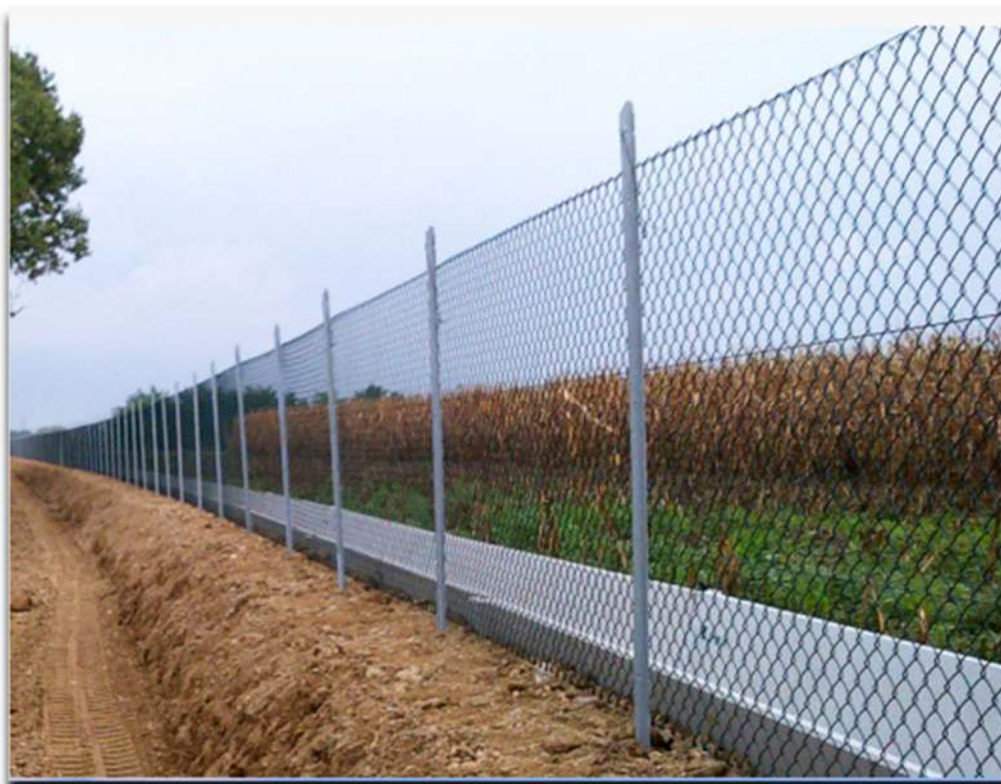
Esempio di recinzione perimetrale
