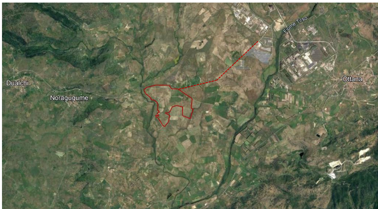
Figura 2.2 Fotografia aerea dell'area del futuro impianto in progetto e del tracciato dell'elettrodotto in cavo interrato
