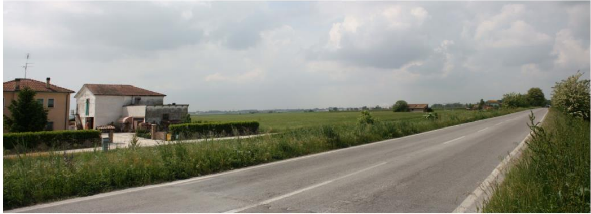
particolare area- visuale nord- sud (dettaglio strada Maria Margotti)
