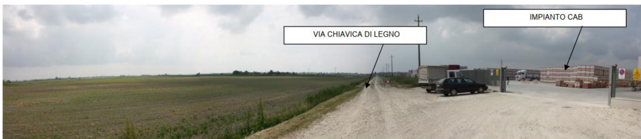
particolare area vincolo paesistico – confine comparto con area industriale a ovest (visuale sud – nord)
