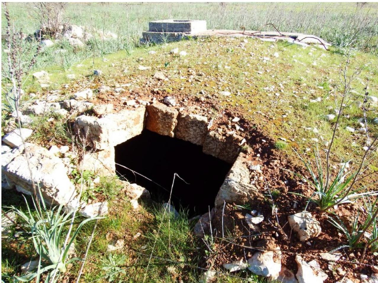
**Fig. 19 – Cisterna raccolta acque piovane interrata presente nei pressi di Masseria S. Elmi**
