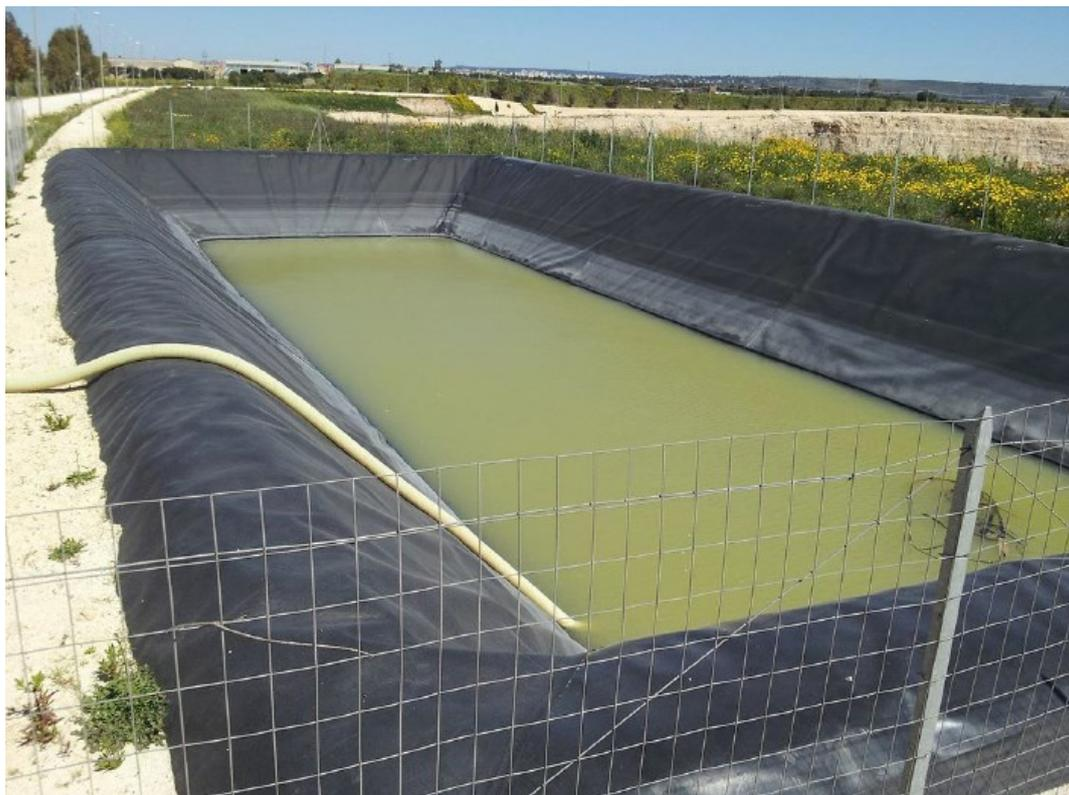
**Fig. 20 – Esempio di vasca raccolta acque piovane**
