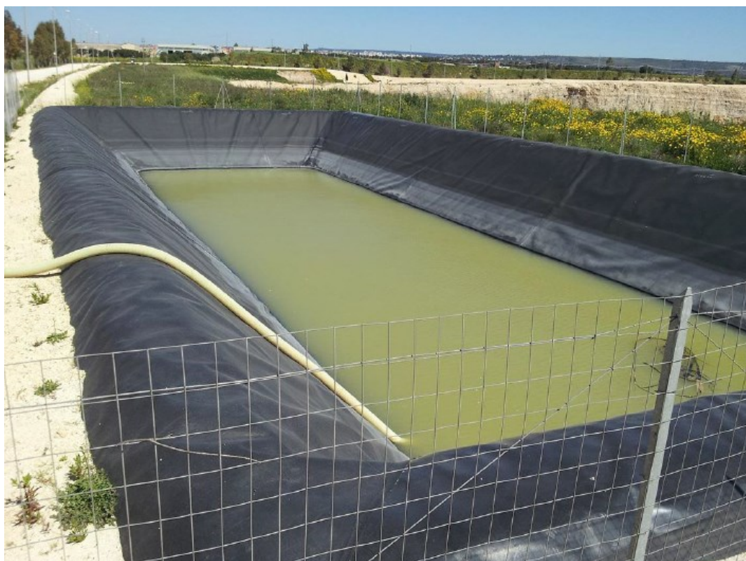
Fig. 28 – Esempio di vasca raccolta acque piovane
