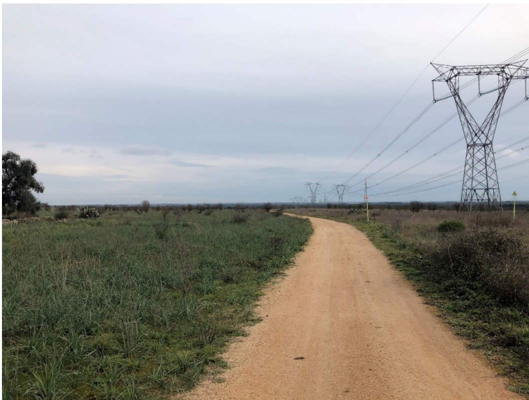
Fig.7 – Foto riportante le interferenze dovute alla presenza di elettrodotti a 150 kV
