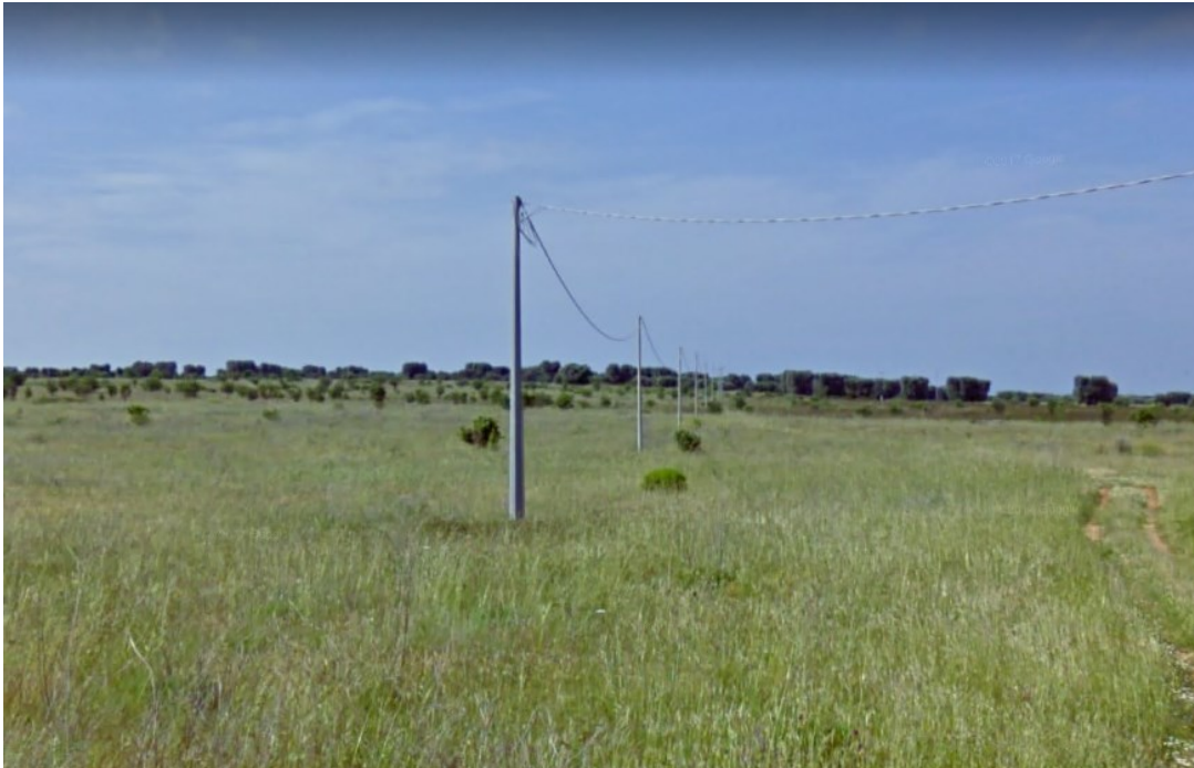
Fig.8 – Foto riportante l’interferenza dovuta alla linea aerea in BT
