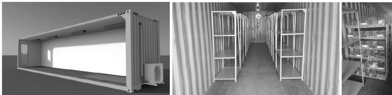
Fig. 42 – Vista interna cabina di stoccaggio materiale
