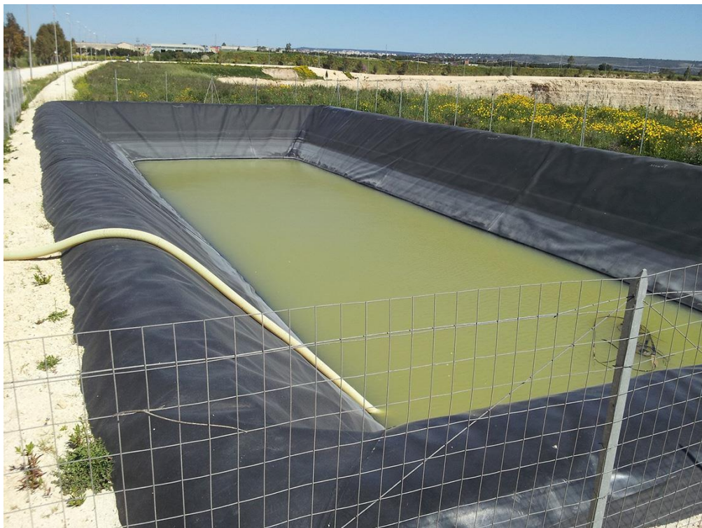
Foto 4 – Esempio di vasca raccolta acque piovane.
