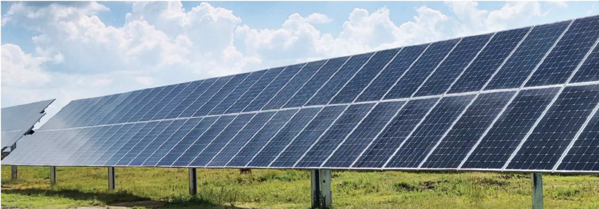
Figura 14 Inseguitore monoassiale vista frontale
