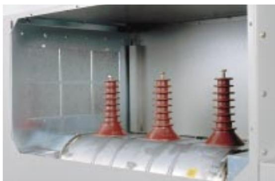
L'involucro in acciaio inossidabile realizza una segregazione metallica messa a terra tra il compartimento sbarre e il compartimento linea dell'unità in cui l'apparecchio viene installato.
