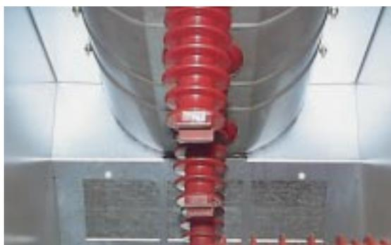
Inoltre, la segregazione metallica realizzata dall'involucro riduce notevolmente le possibilità di corto circuito tra le fasi e tra i contatti superiore e inferiore della stessa fase dovuto a correnti di fuga.
