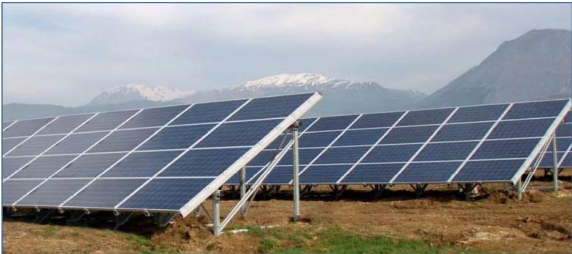
FIGURA 13: INSTALLAZIONE CON 4 MODULI IN ORIZZONTALE SU STRUTTURA FISSA
