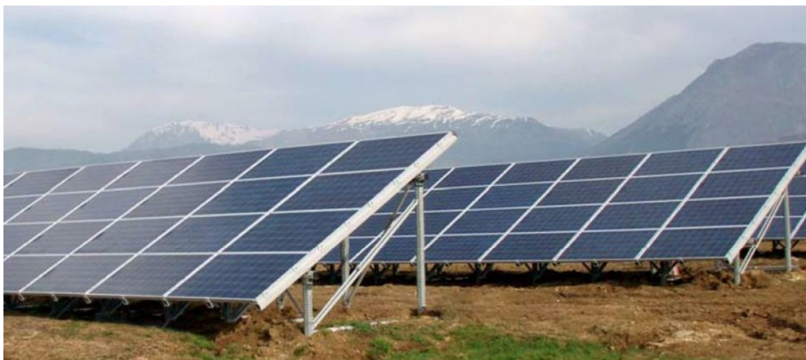
FIGURA 2: INSTALLAZIONE CON 4 MODULI IN ORIZZONTALE SU STRUTTURA FISSA
