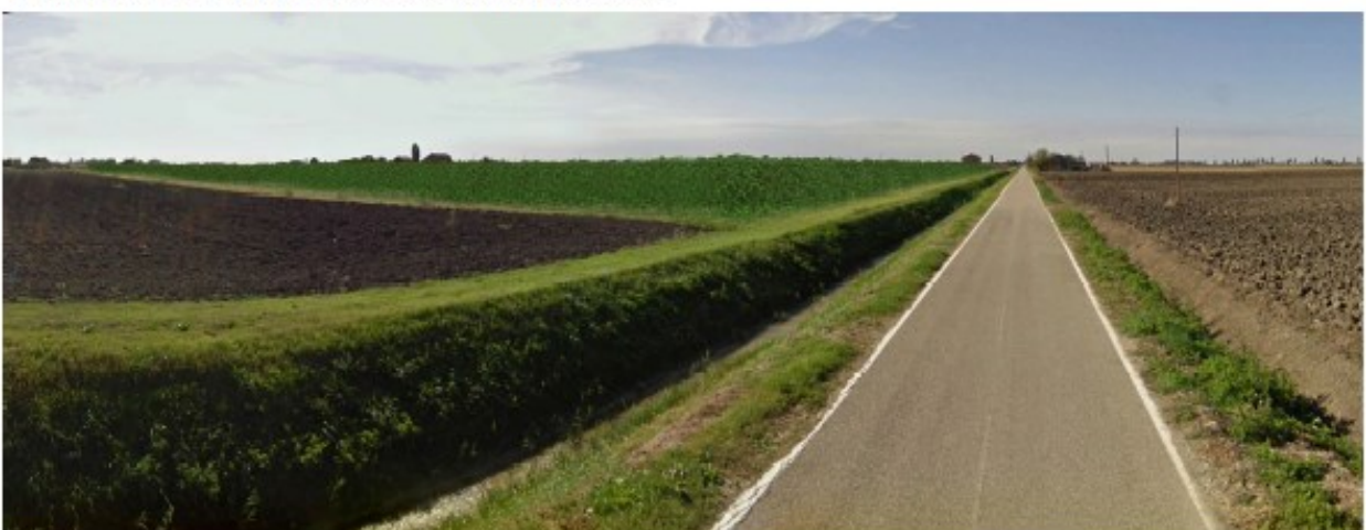
VISTA 01 - POST OPERAM CON FASCIA DI MASCHERAMENTO
