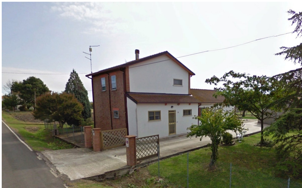
Figura 4-39: Edificio rurale tipico del luogo
