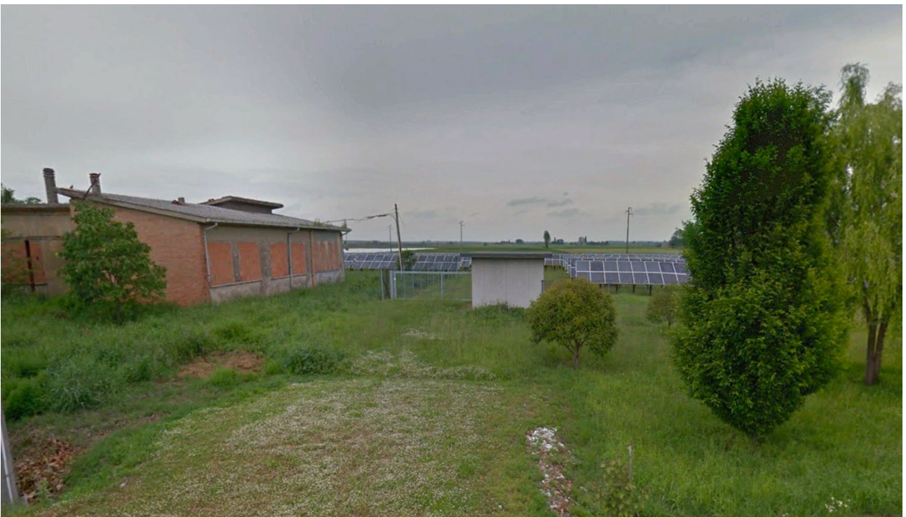
Figura 4-44: Impianto fotovoltaico presente a sud-ovest del Campo B
