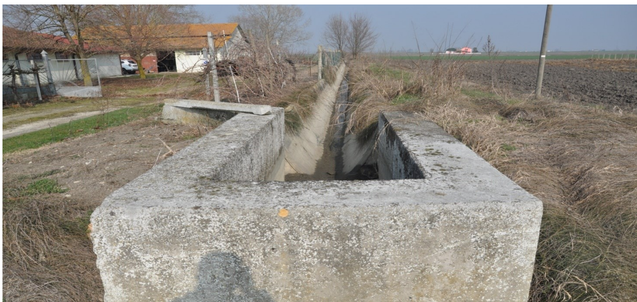
Figura 4-29: Canalina in cemento sopraelevata rispetto al livello del terreno per le risaie
