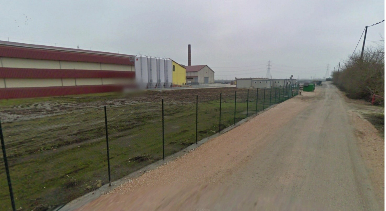
Figura 4-45: Industria di ovoprodotti a nord del sito di progetto delle stazioni.
