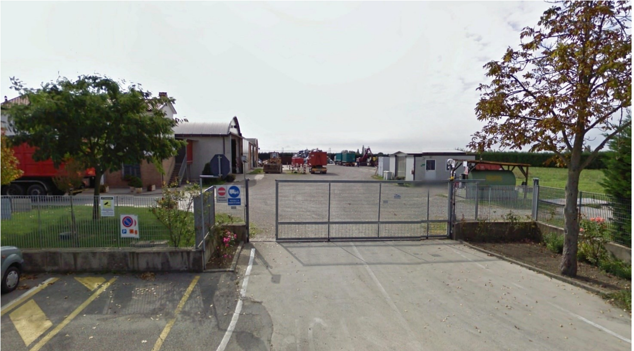
Figura 4-43: Deposito e rivendita rottami a nord-est del Campo A
