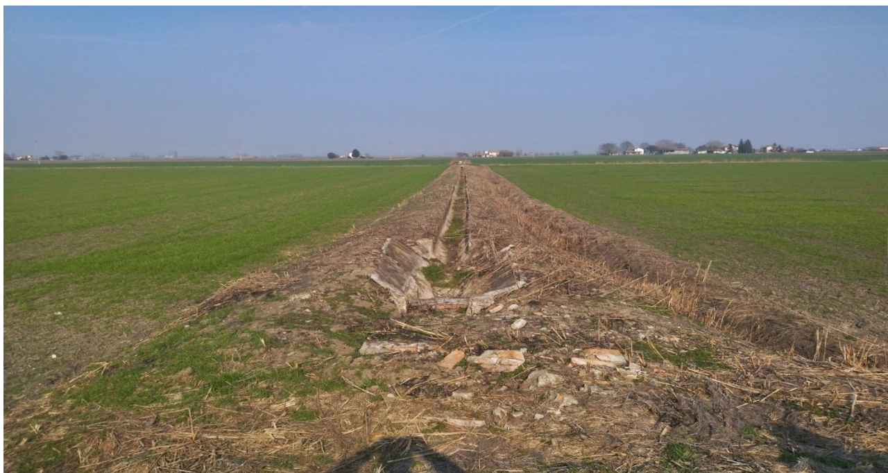
Figura 4-30: Canalina in cemento sopraelevata rispetto al livello del terreno per le risaie
