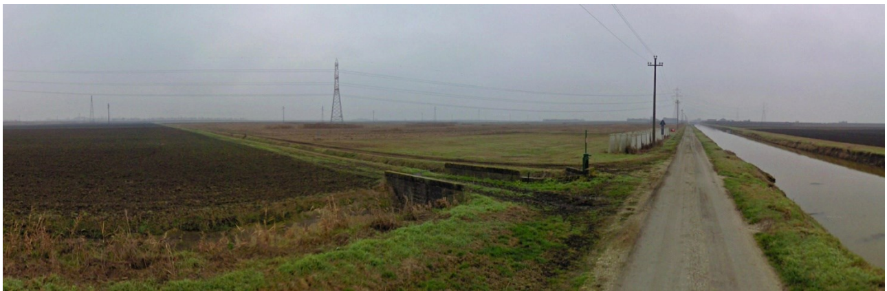
Figura 5-10: Panoramica dell'area in cui sorgeranno le future stazioni elettriche
