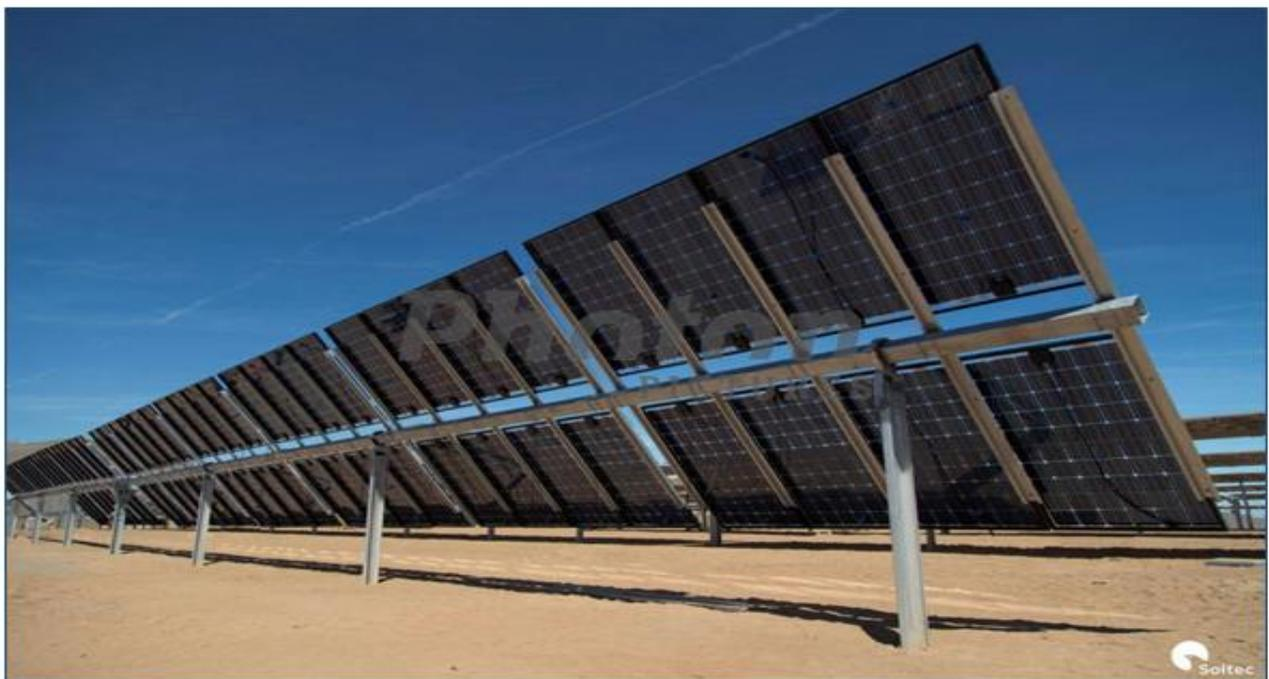
Figura 6 – Impianto con strutture mobili ad inseguimento monoassiali
