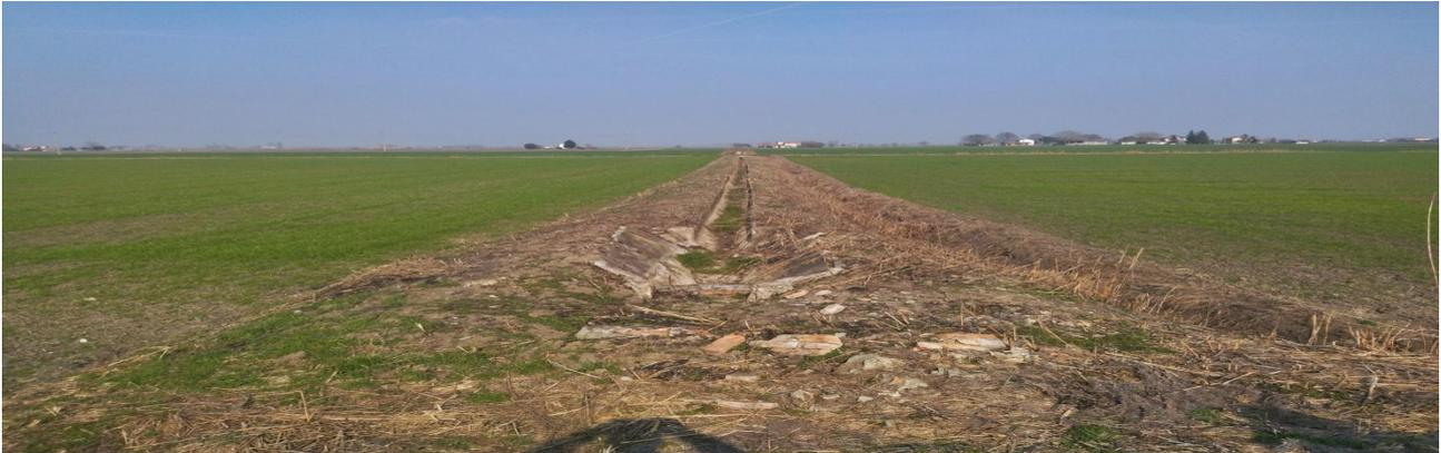
**Figura 10 - Canalina in cemento sopraelevata rispetto al livello del terreno per le risaie**
