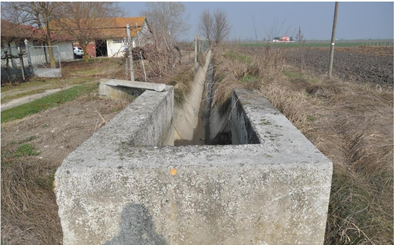
**Figura 9 - Canalina in cemento sopraelevata rispetto al livello del terreno per le risaie**
