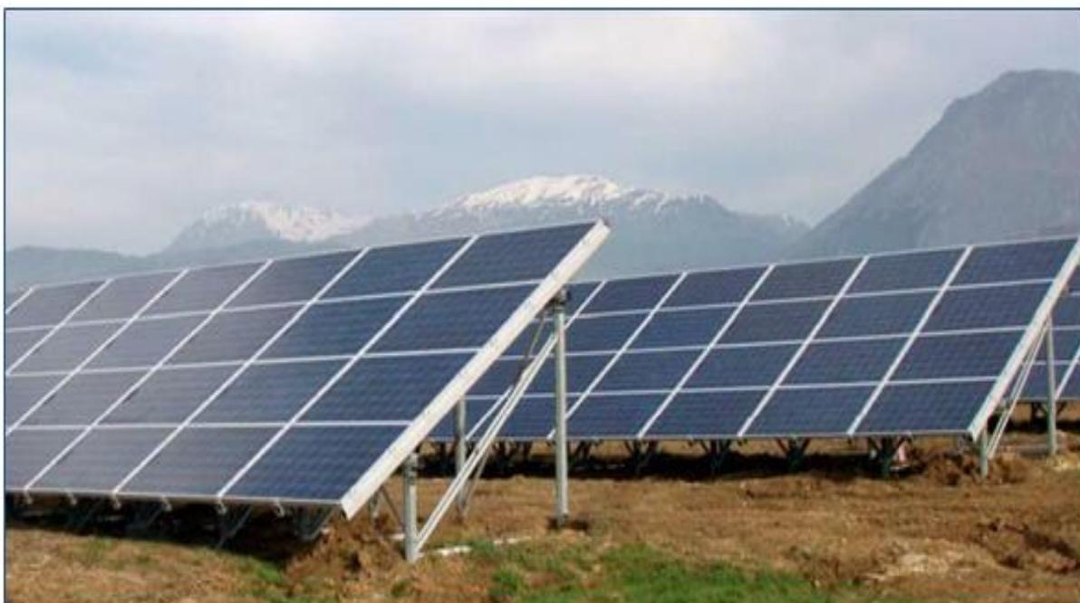
Figura 5 – Impianto con strutture fisse monofilari
