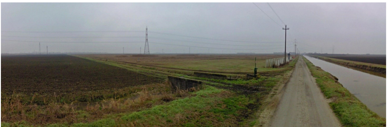
VISTA 15 – Panoramica da Via Canale Bastione (area in cui sorgeranno le future stazioni elettriche)
