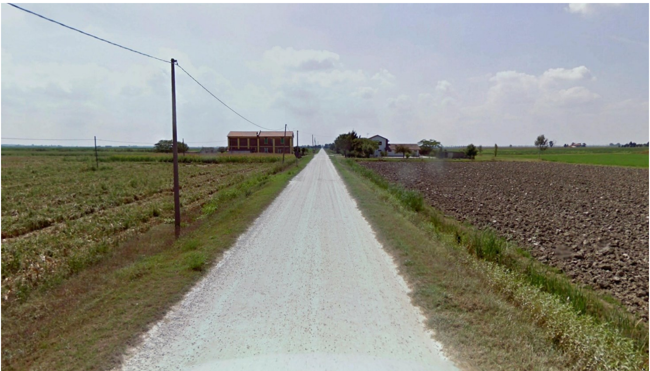
VISTA 12 – Vista del percorso del cavidotto MT dalla Strada reale traversa 6
