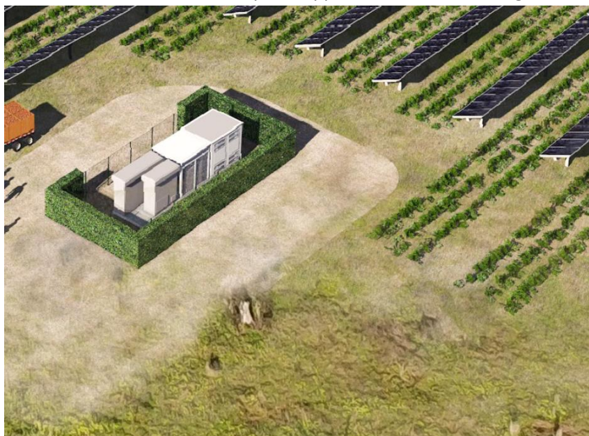
Figura 4: Apparati tecnici inverter e trasformatori di campo
