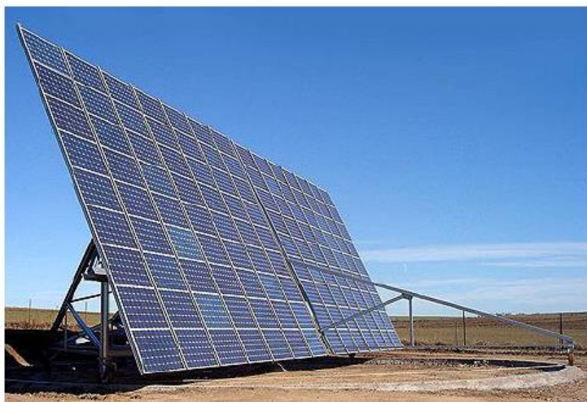
Figura 3.2-2 Inseguitori Azimut- elevazione
