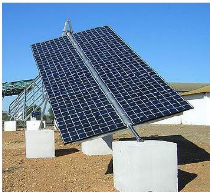
Figura 3.1-5 Inseguitori ad asse polare
