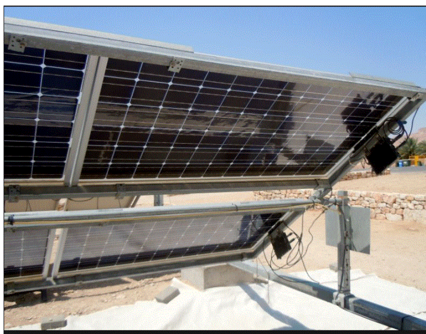
Fig. 5.1-1 Tipico Modulo fotovoltaico Bifacciale
