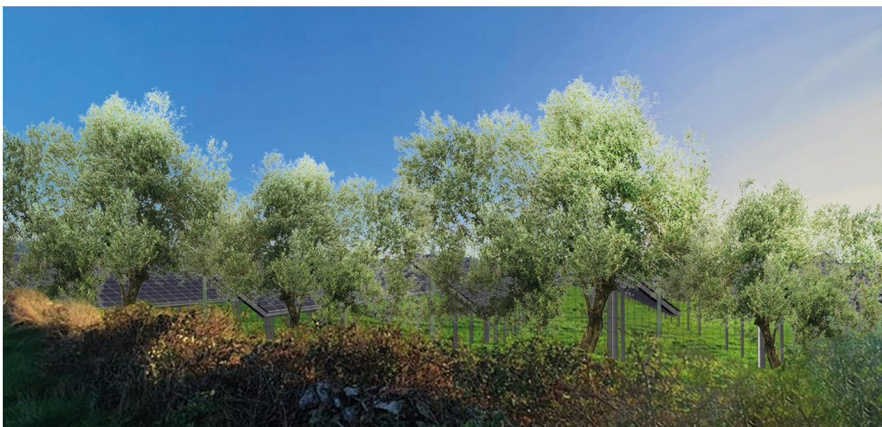
FIGURA 92 – INSERIMENTO DEL PROGETTO ALL'INTERNO DEL CONTESTO TERRITORIALE PRE E POST INTERVENTO – VISTA E – ESTRATTO DALL'ELABORATO GRAFICO SIL-IAT17
