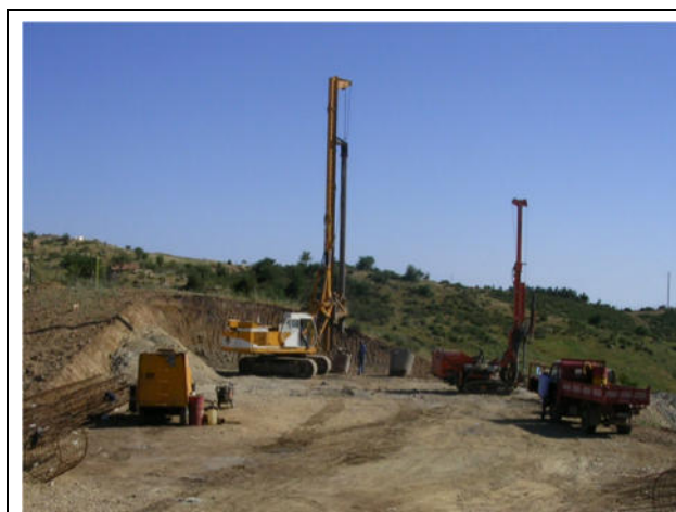
Realizzazione pali trivellati
