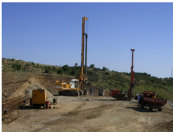
Realizzazione pali trivellati
