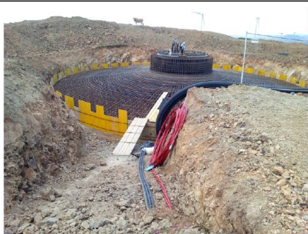
Posa ferri e cassetatura
