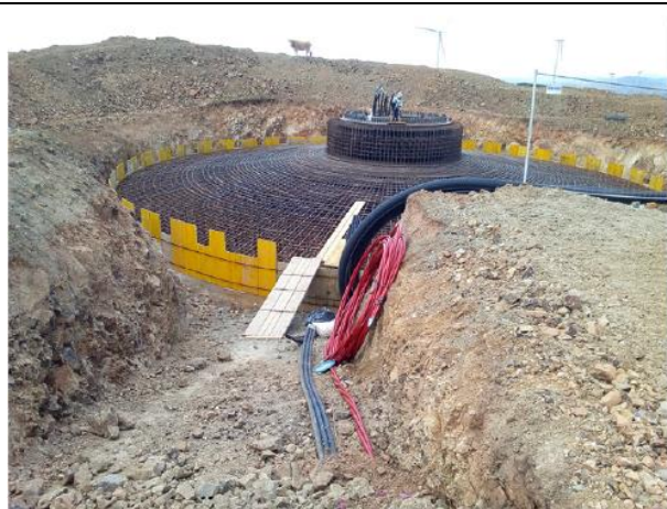
Posa ferri e cassetatura
