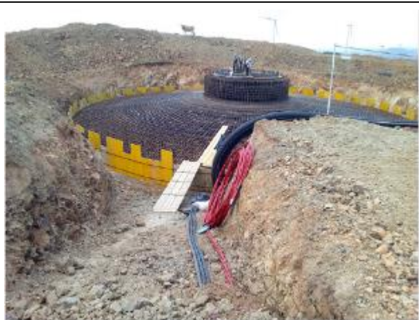
Posa ferri e cassetatura
