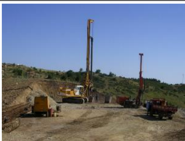
Realizzazione pali trivellati
